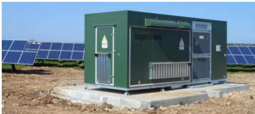
Figure 24 : Exemple d'un local technique transformateur type (source INGETEAM)
