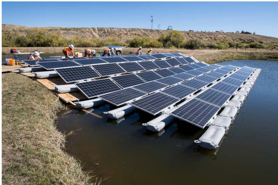
Figure 17 : Exemple de mise à l'eau de structures flottantes - credits: DENNIS SCHROEDER / NREL / Flickr Creative Commons
