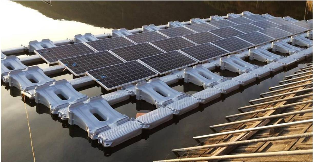
*Figure 10 : Vue zoomée sur les structures photovoltaïques flottantes Ciel&Terre (source : Ciel&Terre)*
