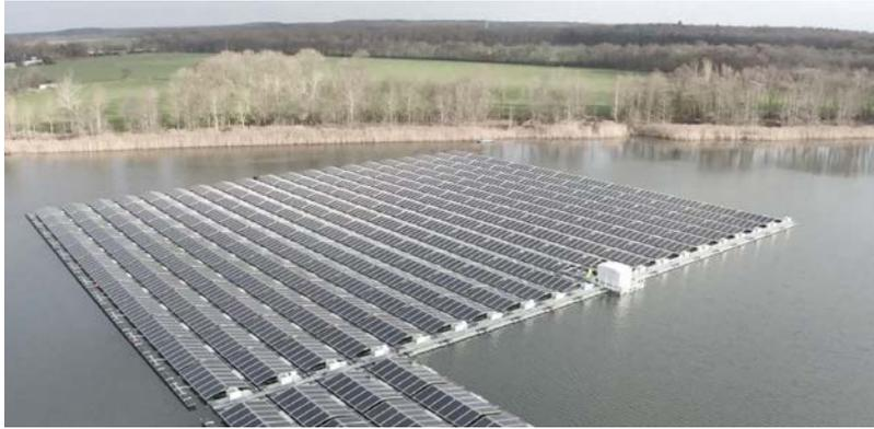
Figure 13 : Exemple de centrale photovoltaïque flottante utilisant des structures Zimmermann (source : Zimmermann)
