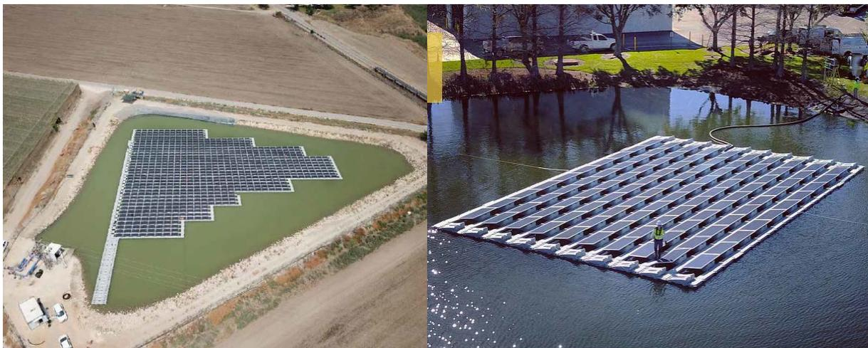
Figure 9 : Exemples de centrales photovoltaïques flottantes utilisant des structures Ciel&Terre (source : Ciel&Terre)
